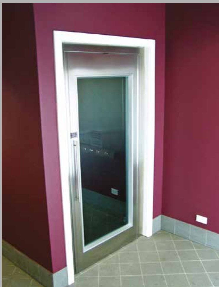
Elfo in Mauerschacht, mit einer einflügelige Panoramatür verkleidet in Inox SB mit Caspim Handgriff
