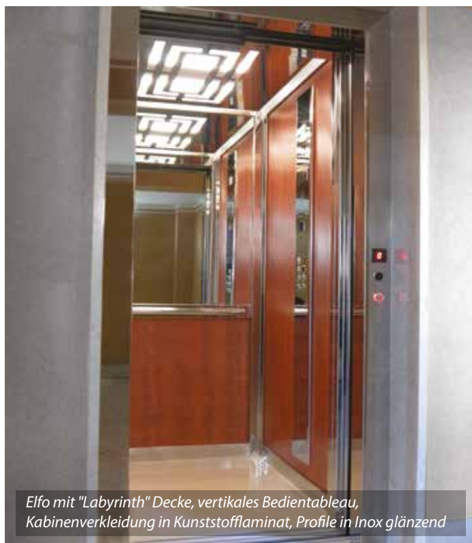
Elfo mit teleskopischen Etagentüren, mit Laminat Verkleidung und Türrahmen in Inox glänzend
