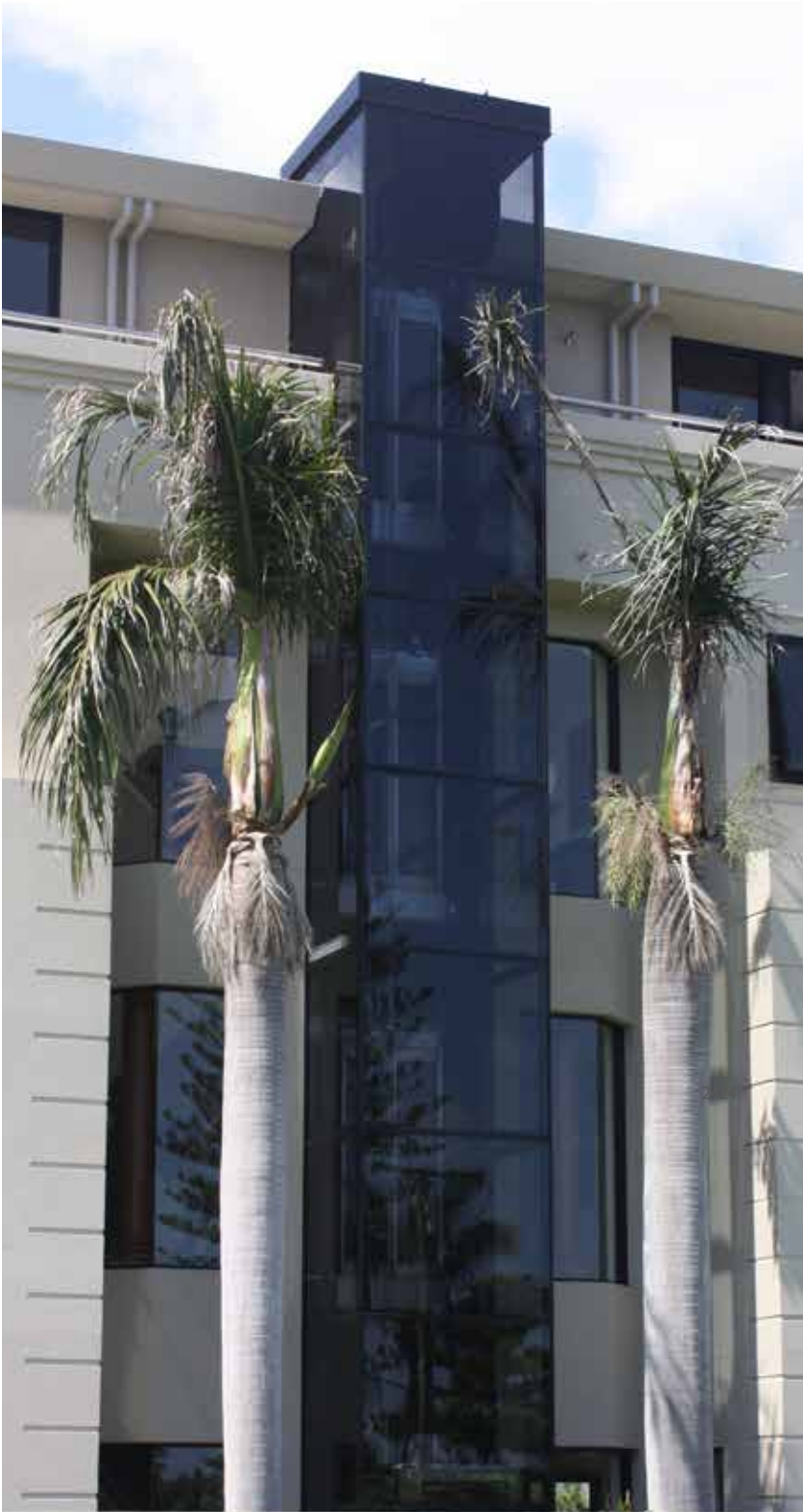
Schacht in spezieller Metallstruktur mit Glasfüllung in fumé, Panorama-Edelstahltüren.
