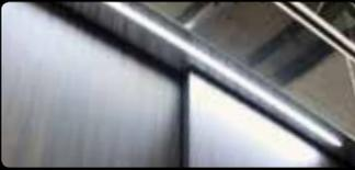
In den Türrahmen integrierte LED-Beleuchtung (nur für automatische Türen)
